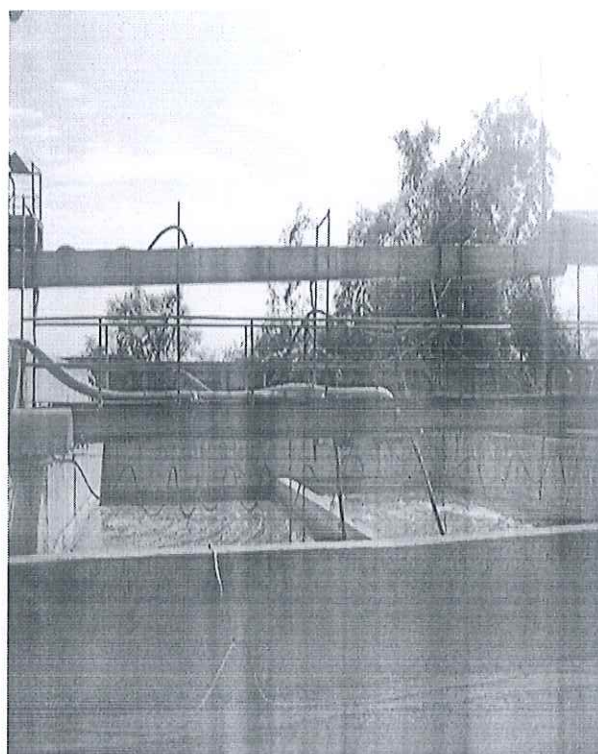
Bể điều hòa
